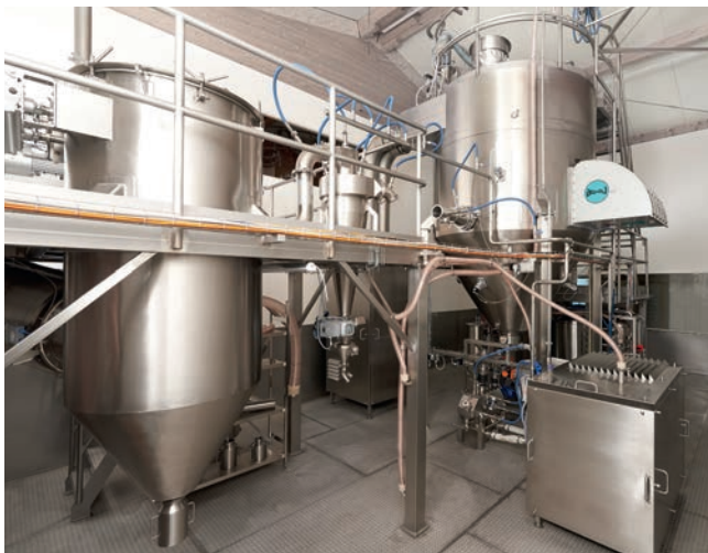
配备均质机和安全设备的中试装置
