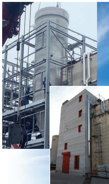
喷雾干燥器 VetterTec CIRRUS NSD 用于婴儿食品配料
